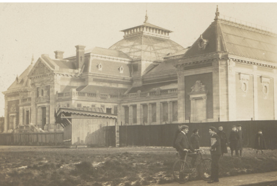
Le musée vue du jardin, état architectural original Archives municipales de Valenciennes, VAL 22 Z 83 (22)
