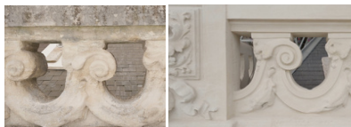
Avant-après des pierres hydrogommées de la balustrade, juillet 2025
