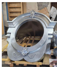
Le parement d'un œil-de-bœuf après sa restauration Juin 2025
