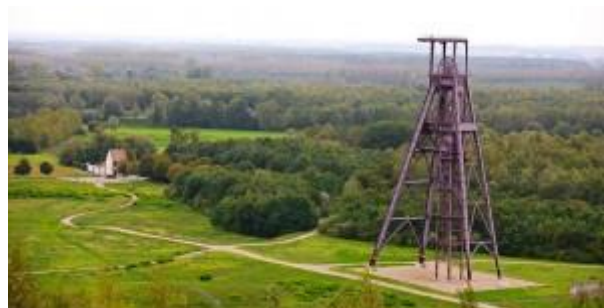
Chevalement de la fosse Ledoux à Vieux-Condé
